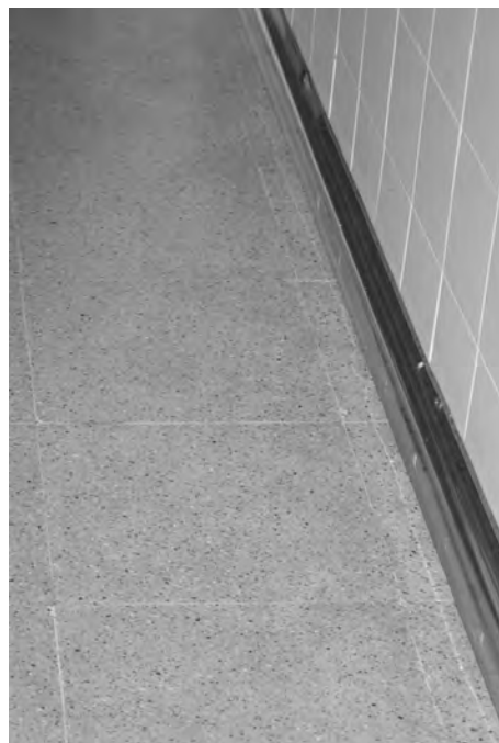
Figura 7.15. Unión de acero inoxidable.
