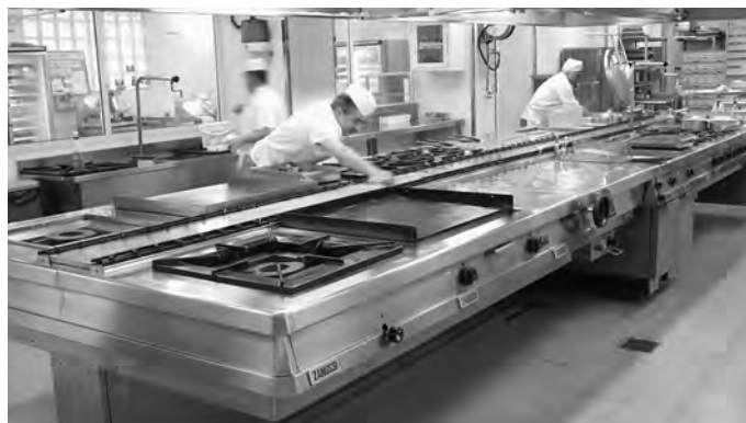
Figura 16.18. Limpieza del bloque de cocción.
