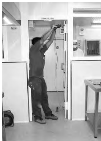
Figura 17.1. Operación de mantenimiento.
