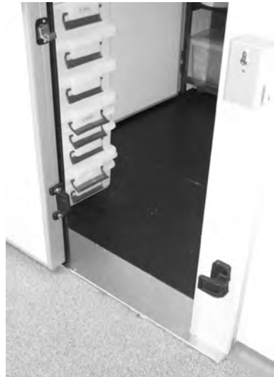
Figura 10.2. Cierre de puerta de cámara sin guía inferior.
