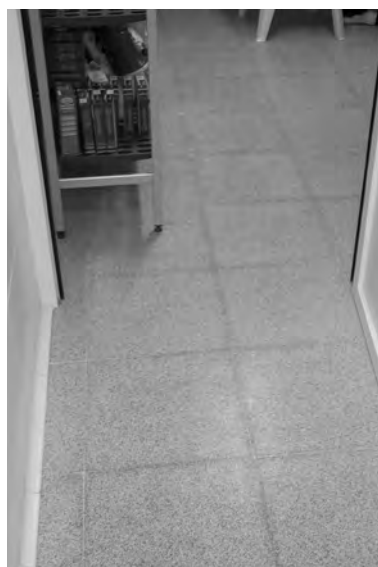
Figura 7.12. Suelo de terrazo.
