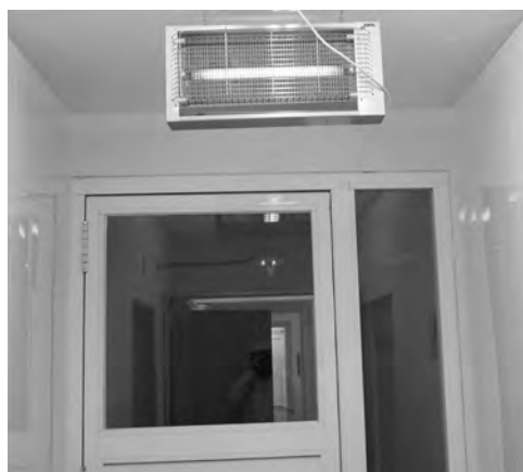
Figura 15.4. Dispositivo electrocutor para insectos voladores.
