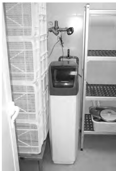
Figura 8.17. Descalcificador de resinas.
