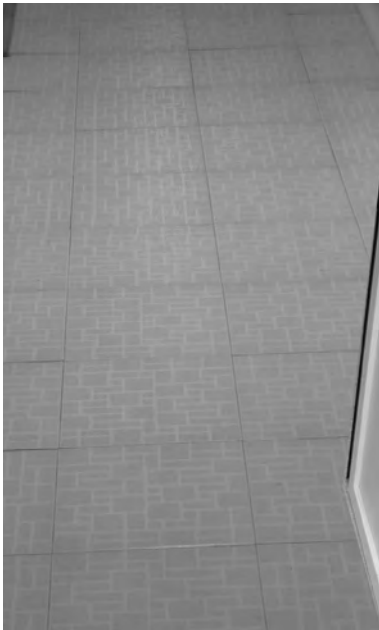
Figura 7.11. Suelo de baldosas cerámicas.
