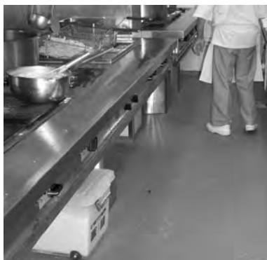
Figura 6.32. Disposición mural del emplazamiento de fogones.
