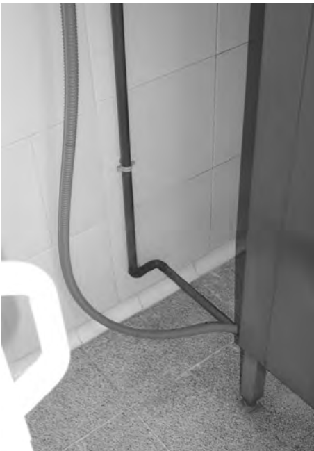
Figura 7.28. Separación de canalizaciones respecto del suelo.
