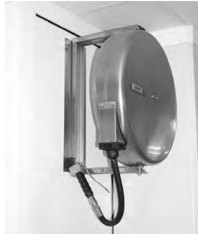
Figura 16.8. Manguera retráctil para limpieza por baldeo.
