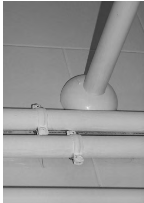
Figura 7.29. Sellado de canalizaciones a la pared.
