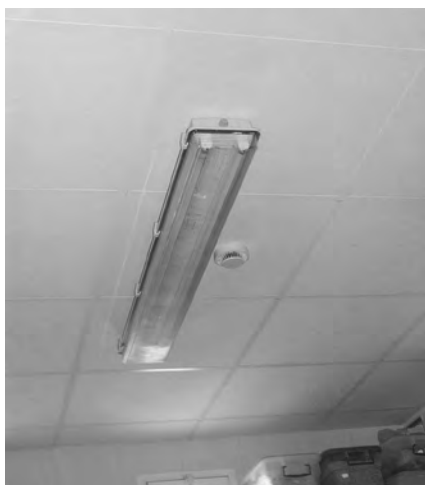
Figura 7.22. Techo suspendido desmontable.
