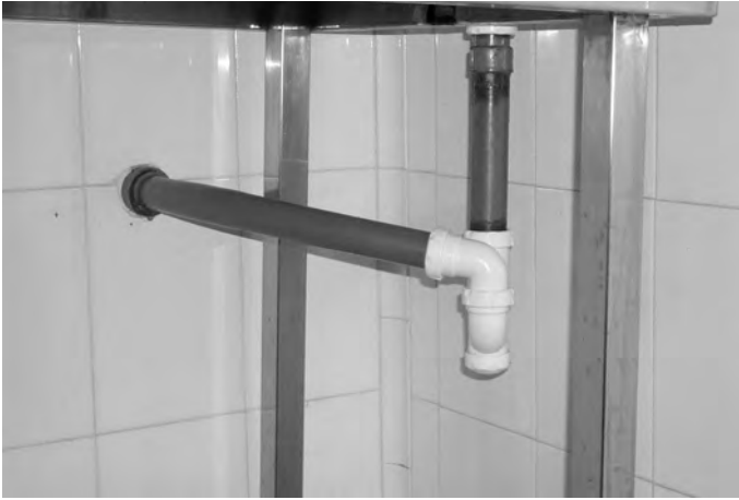
Figura 7.33. Sellado de desagüe a pared.
