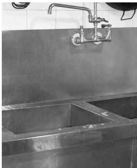
Figura 7.3. Protección de pared detrás de fregadero.
