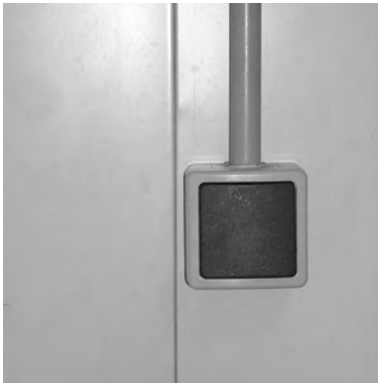
Figura 7.34. Interruptor de fácil limpieza.
