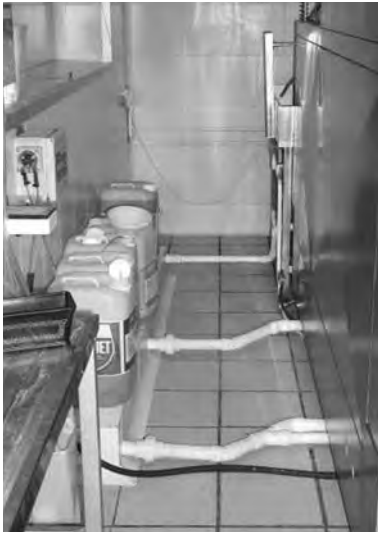
Figura 16.4. Separación del lavavajillas respecto de la pared.
