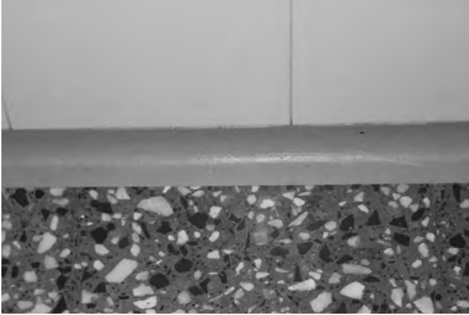
Figura 7.16. Unión de resina.
