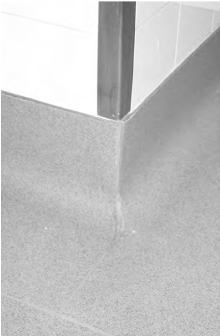
Figura 7.17. Unión de pavimento plástico.
