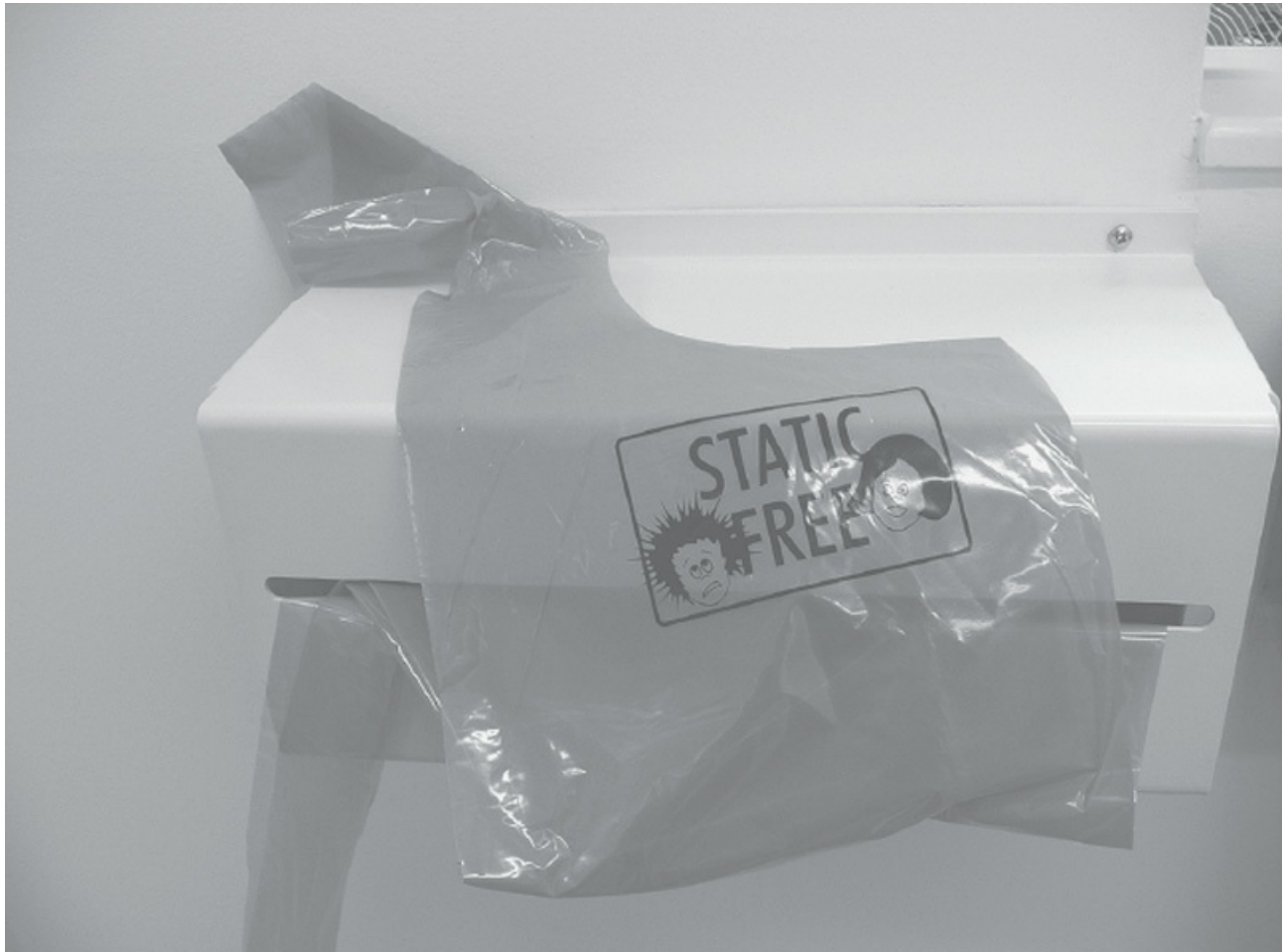
Figura 6-10. Delantales desechables antiestáticos en un despachador montado en la pared.
