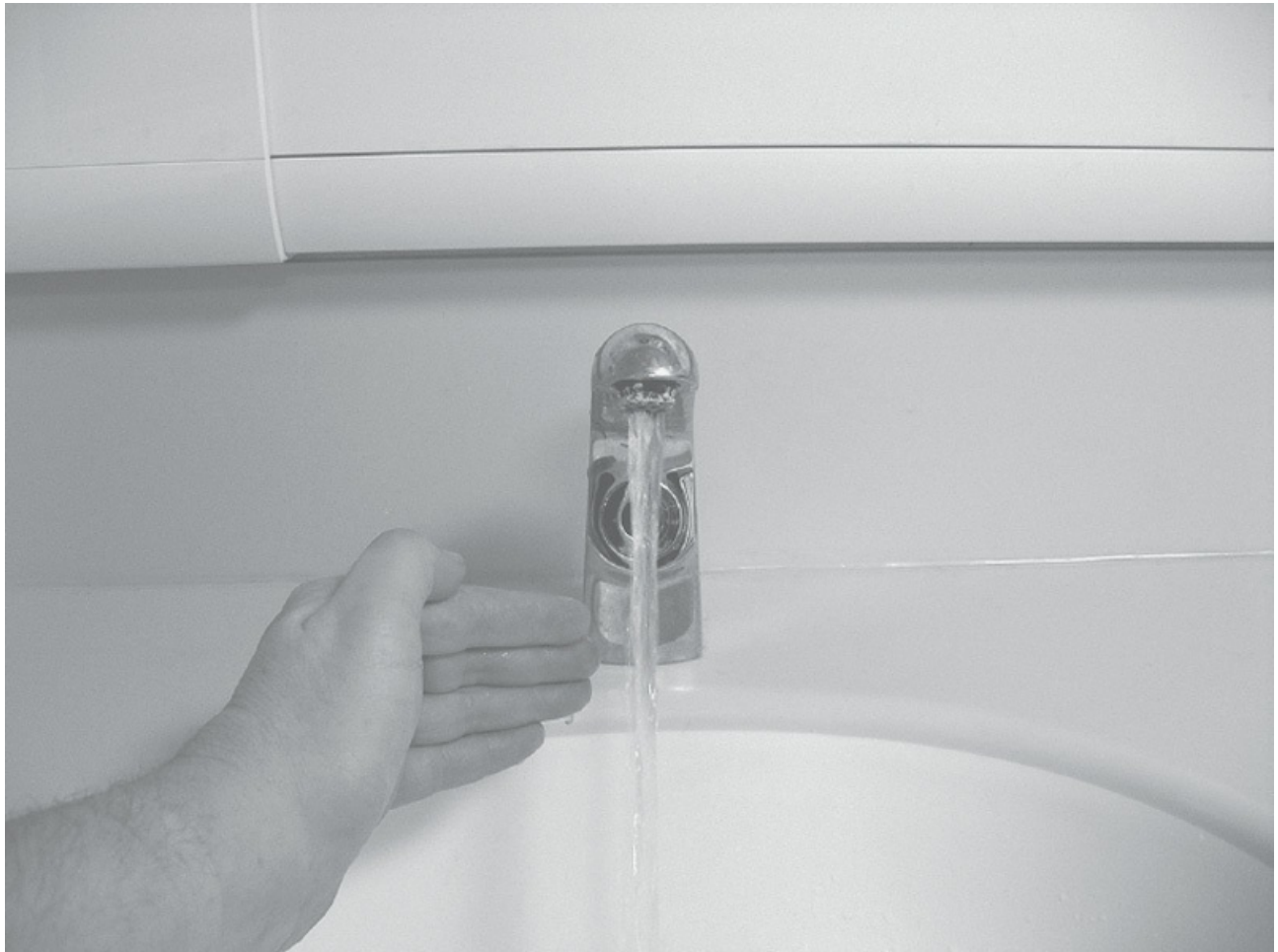
Figura 8-2. Grifo operado por sensor adaptado a un lavabo para lavado manual, nótese que no hay drenaje de sobreflujo.
