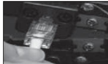
7. Por último, hay que presionar con las tenazas crimpadoras el conector RJ-45 con los cables dentro y apretar fuerte.
