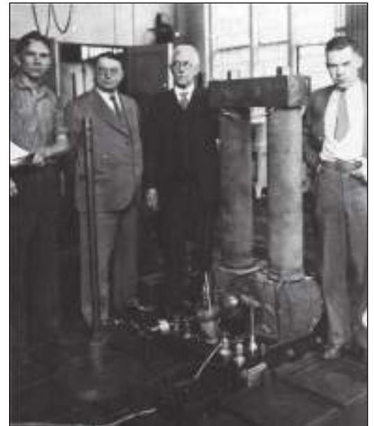
FIGURA 8-41 El primer generador de cd práctico. Ésta es una copia exacta del “Mary Ann de pata larga” que fue el primer generador de cd comercial de Thomas Edison que se construyó en 1879. Sus valores nominales son: 5 kW, 100 V y 1 200 r/min. (Cortesía de General Electric Company.)
