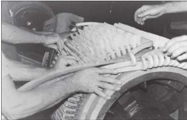
FIGURA 7-12 Instalación de las bobinas preformadas en el rotor de una máquina de cd. (Cortesía de Westinghouse Electric Company.)
