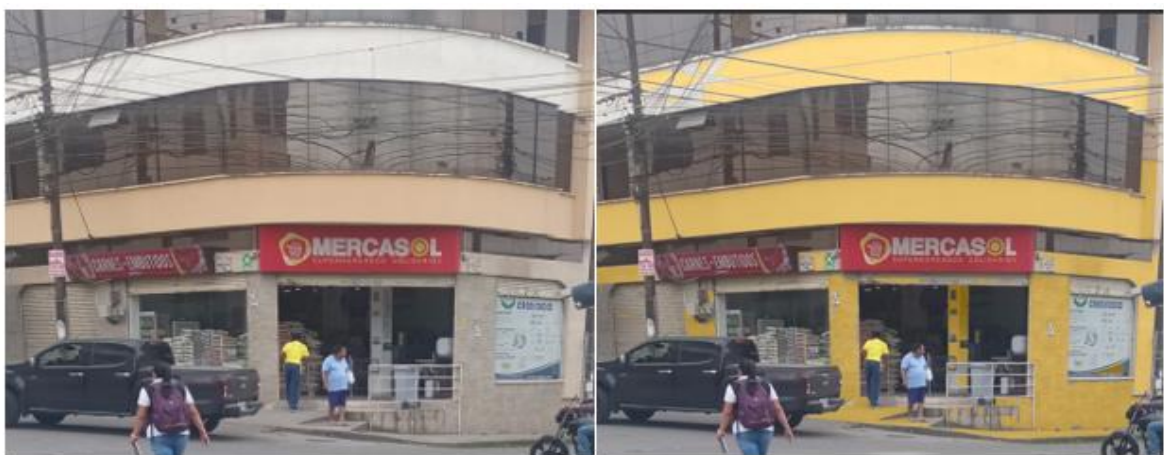
Figura 12. Pintado de fachada.
