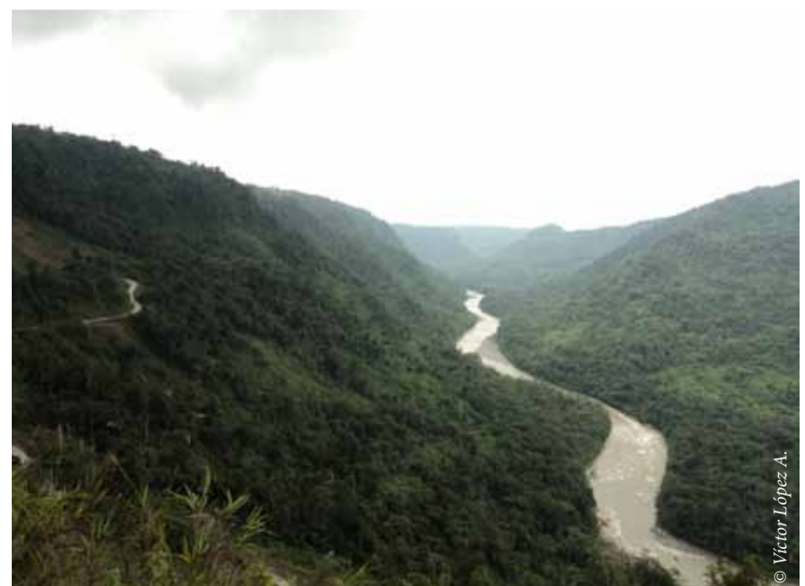
Vista al río Coca desde la vía de acceso a casa de máquinas del proyecto hidroeléctrico Coca-Codo Sinclair. Provincias de Napo y Sucumbíos.
