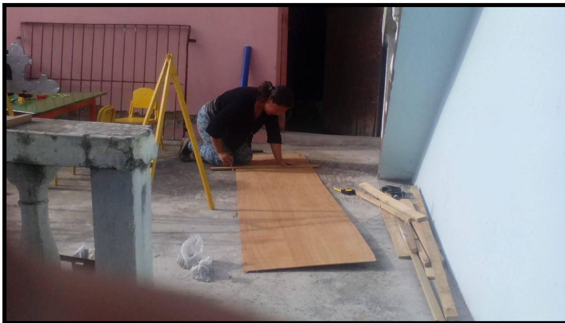
Construcción de los caballetes para el rincón de arte
