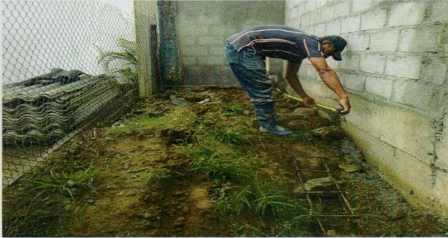
Construccion del arenero
