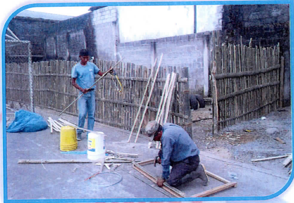
CULMINACION DEL CERCO
