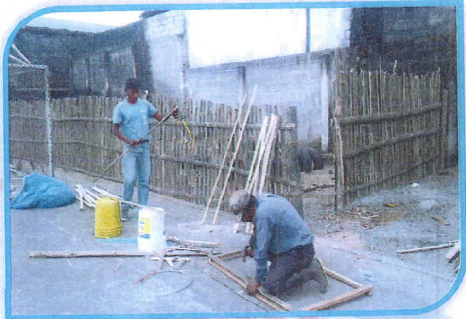
CULMINACION DEL CERCO
