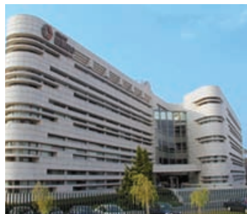
Edificio corporativo de Grupo Bimbo en México.
