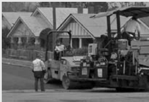
FIGURA 6.6 Los trabajos de repavimentación requieren de un gran esfuerzo de coordinación
