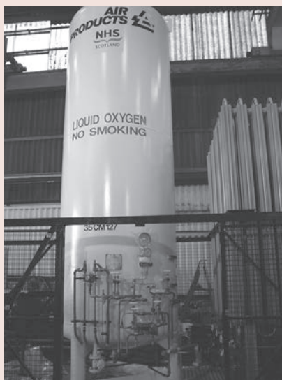
Figura 12.6. Tanque de oxígeno líquido. Se observa a la izquierda el vaporizador y a la derecha termos de O 2
