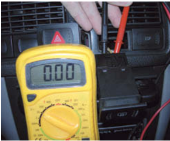
↑ Figura 10.32. Comprobación de la tensión con el interruptor desconectado.
