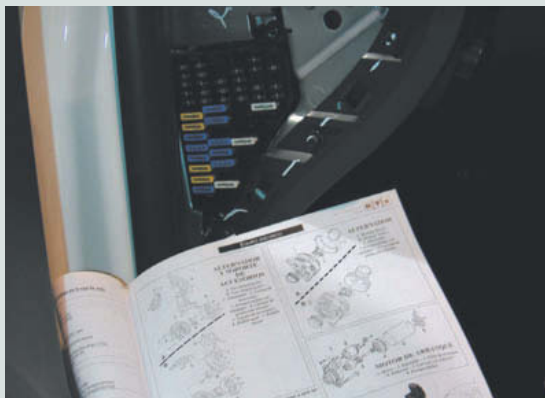
↑ Figura 2.46. Caja de fusibles.
