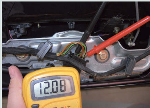
↑ Figura 10.70. Comprobación de la tensión de alimentación del motor.
