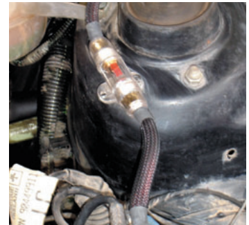
↑ Figura 5.27. Instalación de un fusible aéreo.
