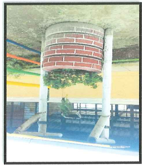
El pozo ya terminado
